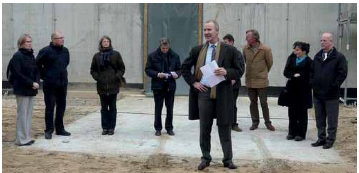
RWFG- Geschäftsführer G. Janßen (Mitte) freut sich über den Baufortschritt in Wildau
